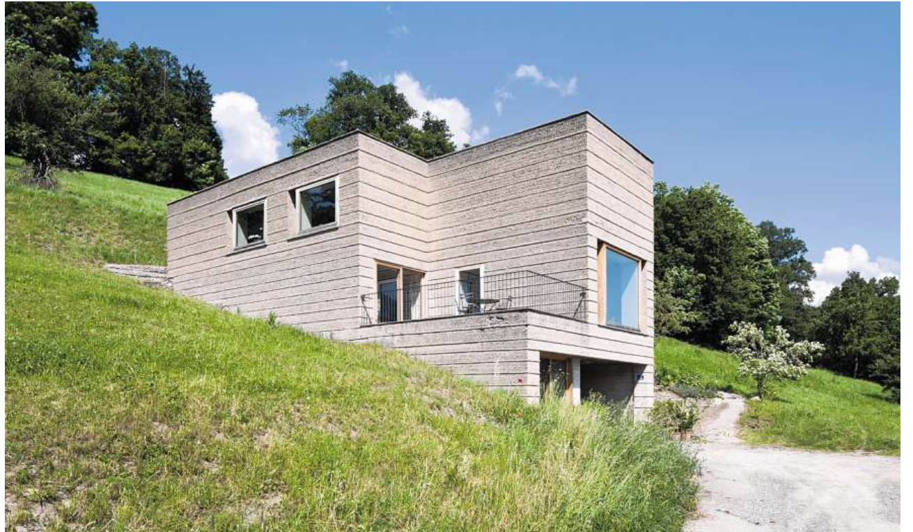
Nicht in Afrika: Das Wohn- und Atelierhaus Rauch im österreichischen Schilns – gebaut aus dem Aushubmaterial der Baustelle – gilt als Paradebeispiel moderner Lehmarchitektur.
