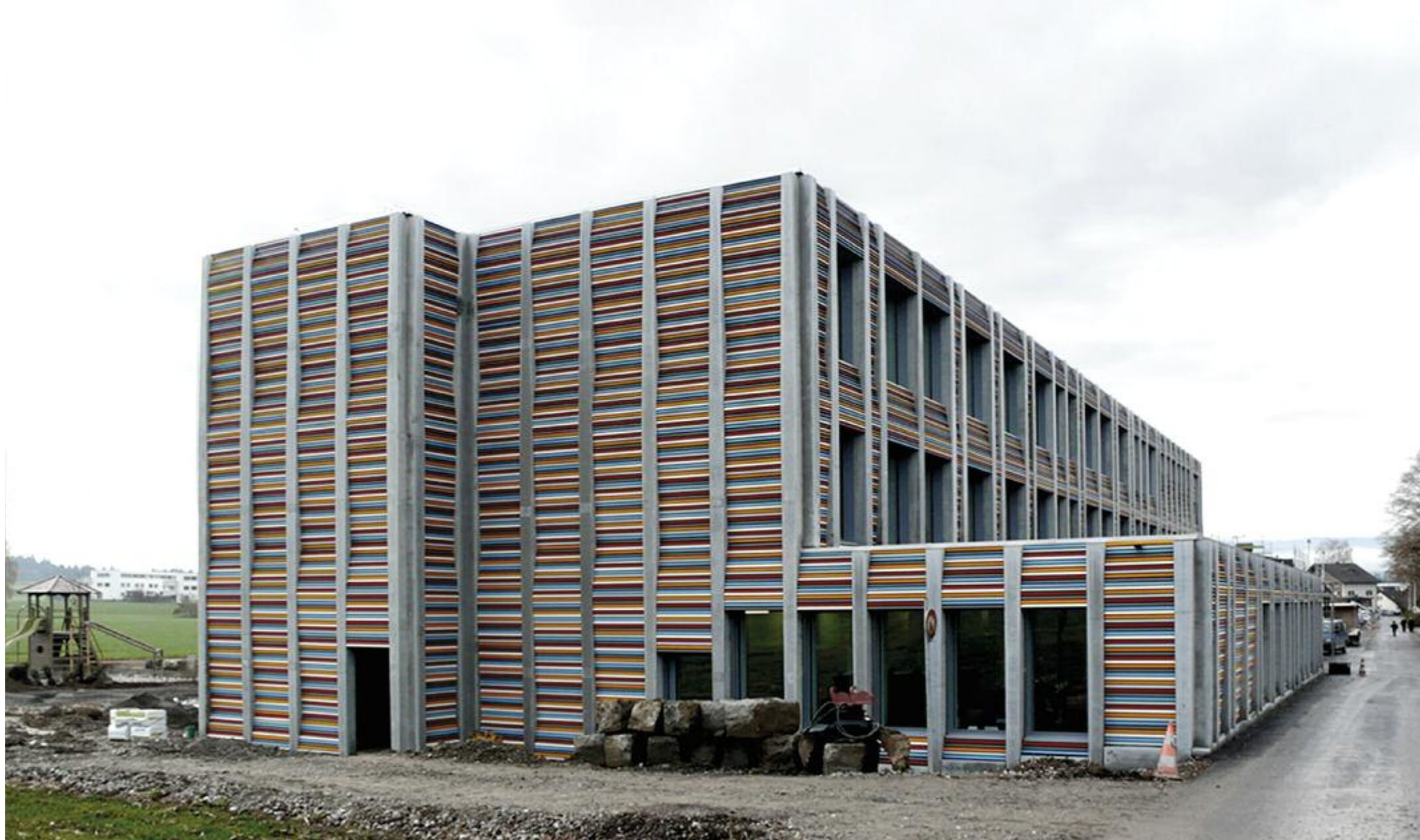
SCHULANLAGE HAGENDORN / Architektur: D. Jüngling und A. Hagmann, Chur Fassadengestaltung mit Alu-Lamellen / Rasterkomposition mit 6 Farben / Wettbewerb: Zusammenarbeit mit Mayo Bucher, Zürich
